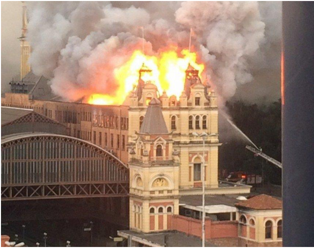
Figura 13: Incêndio no Museu da Língua Portuguesa
