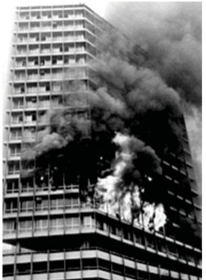
Figura 6: Incêndio no Edifício Joelma
