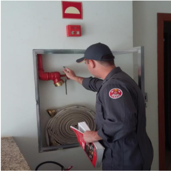
Figura 3: Vistoria em edificação para verificação das medidas de segurança contra incêndio e pânico.
