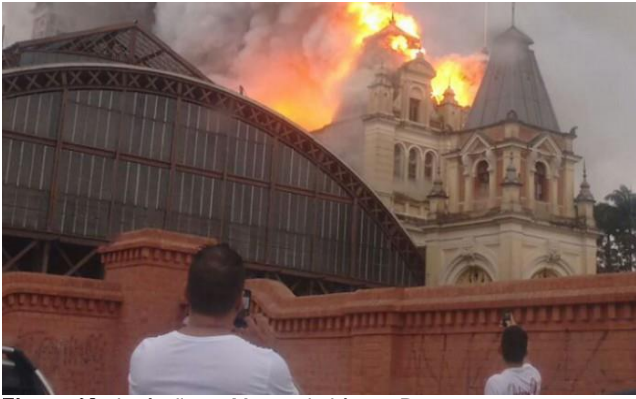
Figura 12: Incêndio no Museu da Língua Portuguesa
