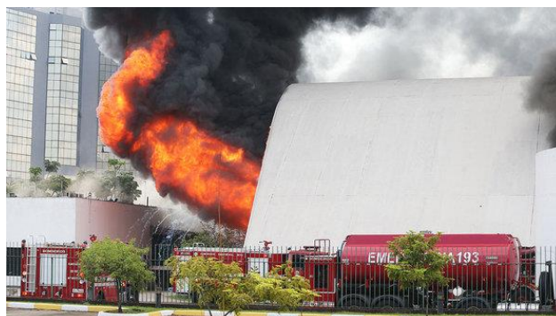
Figura 11: Incêndio no Memorial da América Latina
