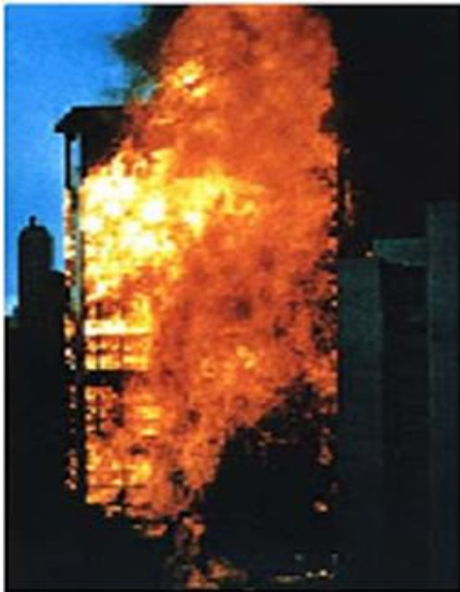
Figura 4: Incêndio no Edifício Andraus
