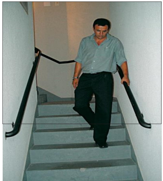
Figura 36: Escada com largura apropriada para saída das pessoas
